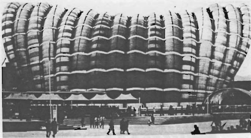
Fig. 11 - Fuji Pavilion EXPO 70 [OSAKA]
